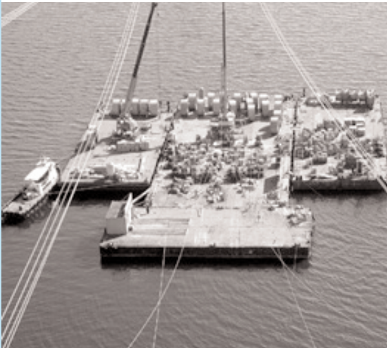
〈연선 변환장치를 이용한 연선공사 전경〉
