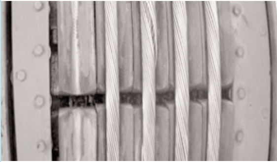
〈전선 꼬임방향 불일치 시공에 따른 전선 부풀림 및 휨 현상 사진〉
