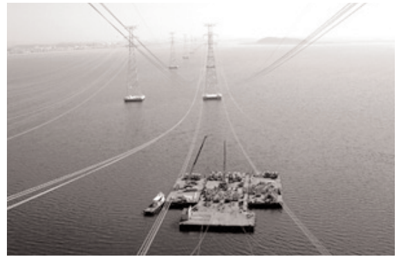
〈연선 변환 장치를 이용한 연선공사 전경〉
